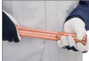
継手をゆっくりスライドさせて止まるまでパイプに挿入して下さい。
