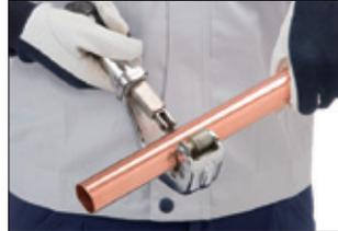
パイプカッターでパイプを切断して下さい。
