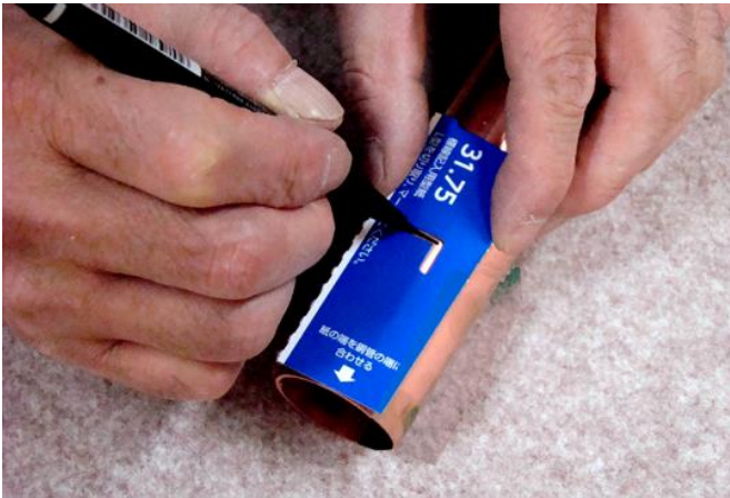
切り込み内を油性フェルトペンで印しを付ける
