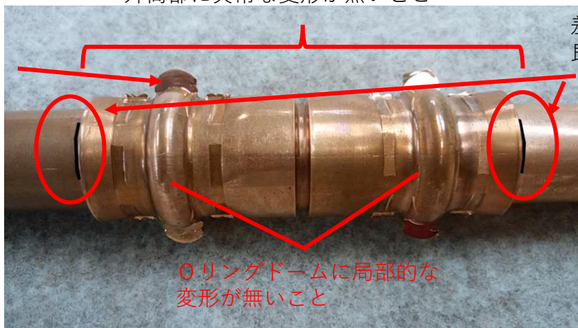
R G プレス6.35mm～19.05mm用の正常な施工完了状態
