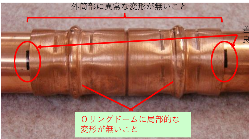
R G プレス22.22mm～38.10mm用の正常な施工完了状態
