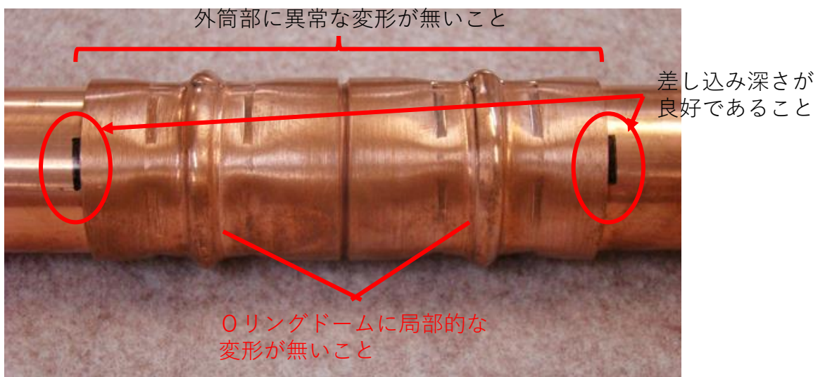
R G プレス22.22mm～38.10mm用の正常な施工完了状態
